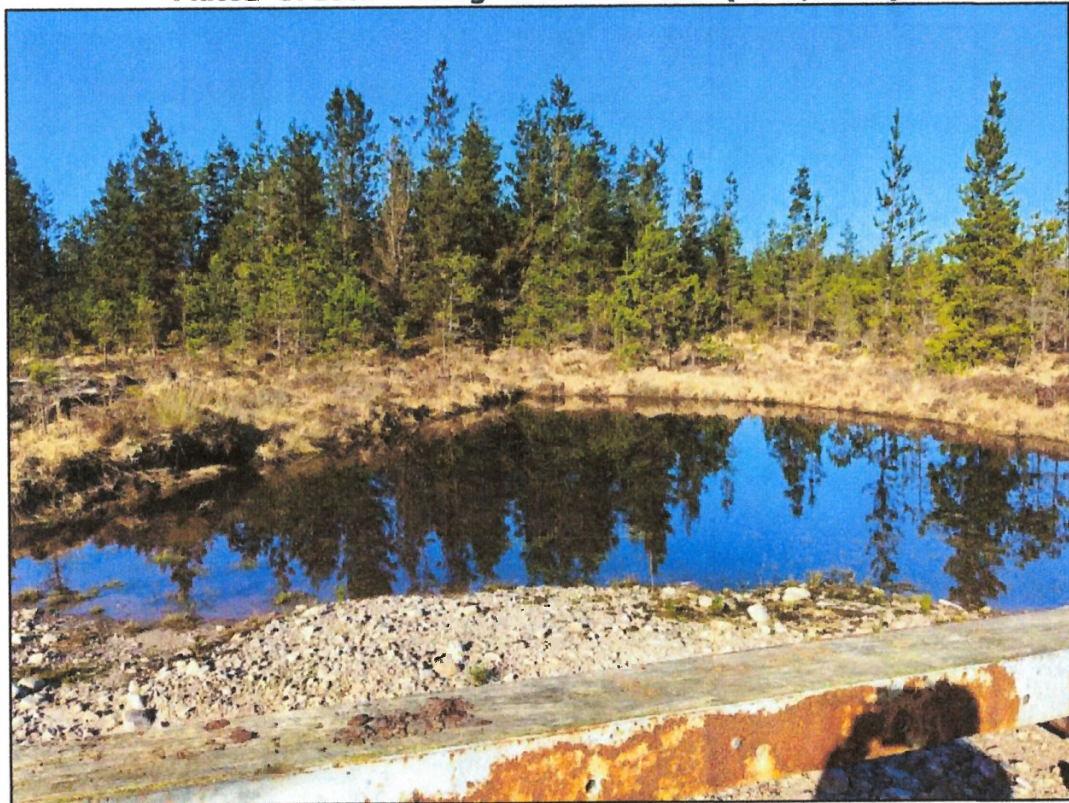
Plate1-4. On site Ponding (AWN 2025)
